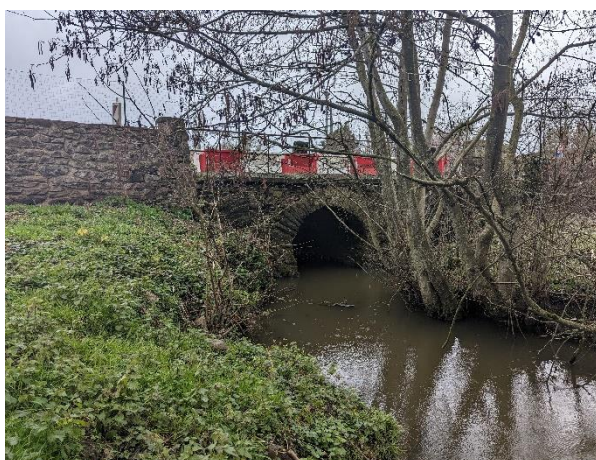
Vue de l'ouvrage en amont de La Baconne
