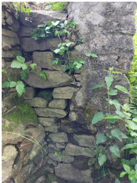
Pile du pont (amont)
