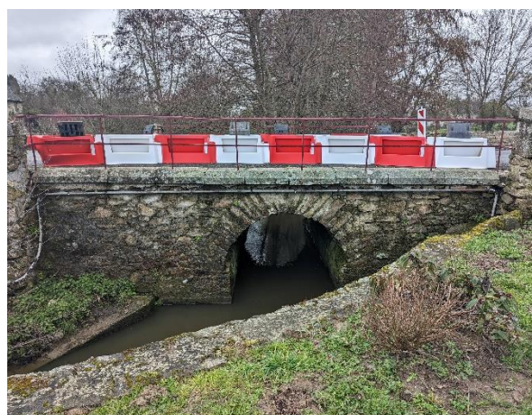
Vue de l'ouvrage en aval de La Baconne
