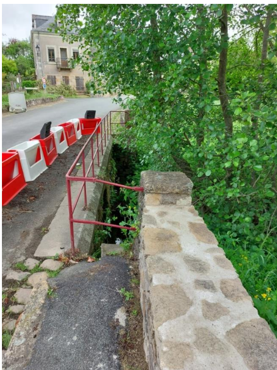
Muret en pierre
