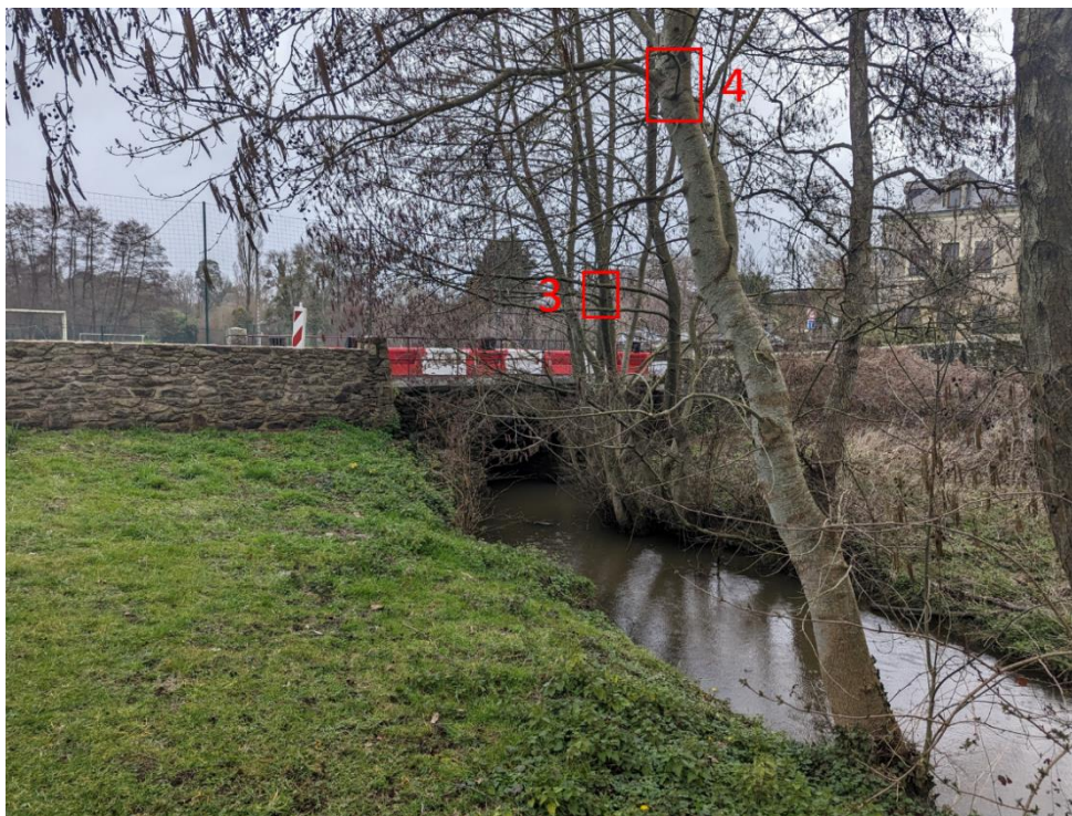
Emplacement préférentiel des gîtes artificiels à chiroptères en amont du pont
